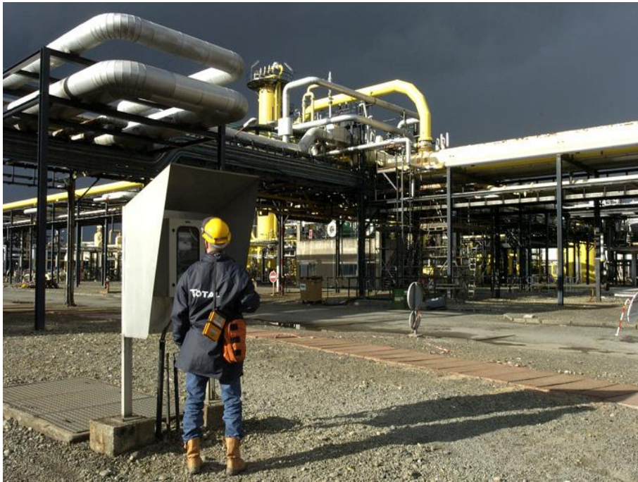
Usine de désulfuration du gaz de Lacq-Mourenx ( document Total.com)
